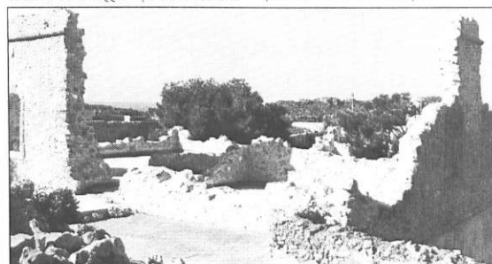
Ο άνω όροφος του κτιρίου της Καγγελιαρίας. Στριχόθηκαν τα ασπυμεινάρια του κτιρίου, αλλά η ανακατασκευή του ορόφου έμεινε γ' αργότερα.
