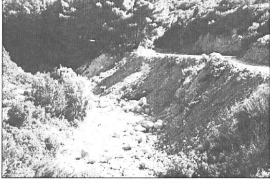
Όλο το χώμα των κατολισθησεων στο δρόμο του Καψαλίου μεταφέρθηκε στο παρακείμενο λαγυάδι, όπου ορίστηκε απλά χωρίς να έχει γίνει τοίχος που να το συγκρατεί. Έτσι που με τις πρώτες βροχές θα παρανορθεί στη θάλασσα και μαζί με τα λυμάτια που κυλούν στο ίδιο ρέμα θ' αποτελέσουν τη βάση για την καταστροφή του βιοτόπου.
