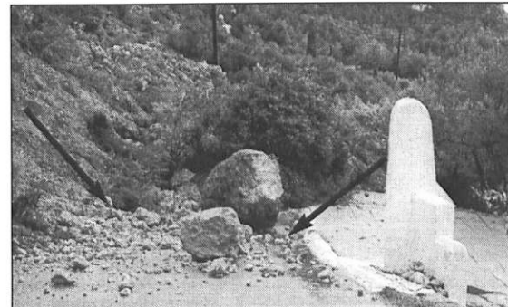
Ο δρόμος του Καψαλίου στην περιοχή που είναι τα «Σπίτια Βασιλη», η είσοδος των οποίων διακρίνεται. Ο δρόμος έχει καλυφθεί με όγκους χωμάτων, μερικά δέ έχουν προχωρήσει στο τμήμα κάτω απ' αυτόν, ενώ άλλα περιμένουν τη ...σειρά τους για να κατηφορίσουν (Τα βέλη δείχνουν πού ήταν ο δρόμος). (Φωτ. Γ. Λευθέρης)
