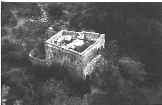
Κτηριακό συγκρότημα νερόμυλου σε δυσπρόσιτη περιοχή της ρεματιάς.
