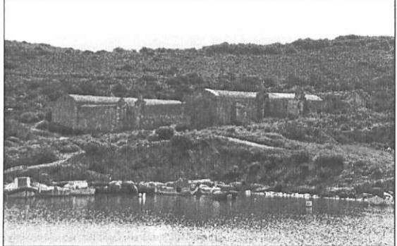
Τα Αλαζαρέττα στο Καψάλι, όπως χτίστηκαν κατά την αγγλοκρατία. Τώρα τα συγκρότημα είναι στα χέρια ιδιώτη από τη Γαλλία, μετά από αδυναμία των αρχών να τα αποκτήσουν και να τα αξιοποιήσουν. Εδώ γινόταν η «υποκάθαρσις» των ταξιδιωτών. (Φωτ. Αρχ. «Κ»)
