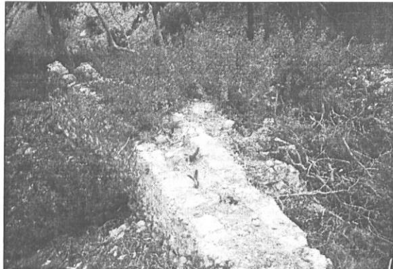
Ο τοίχος με το ανάλα που μετέφερε το νερό με φυσική ροή από το λαγούμι στο περιβόλι του Αγίου Ιωάννου του Εγγρημού. Τοποθεσία Πατινός.
