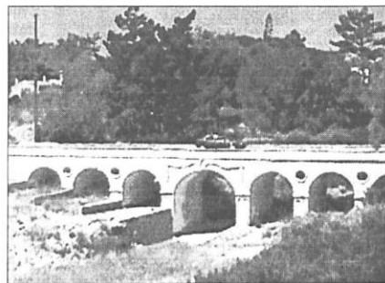
Το γεφύρι του Ποταμού ενισχυμένο. Τα τοίχια όμως καίβουν τις κολόνες. Θα διορθωθεί το ατόπημα;
