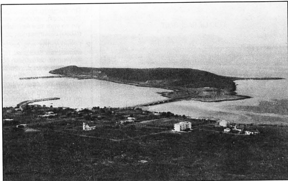
Το λιμάνι ασφαλείας στο Διακόφτι όπως είναι σήμερα
